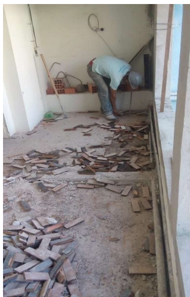
Remoção do Piso de madeira
