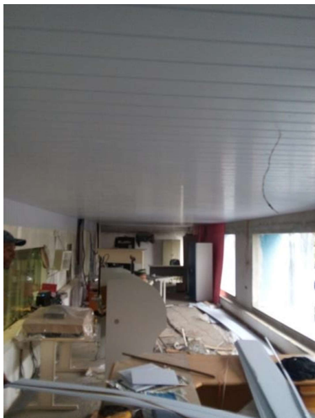
Instalação do Forro em PVC
