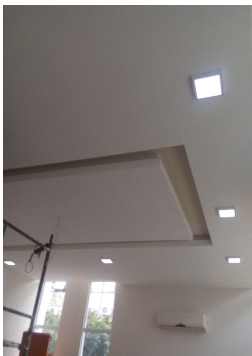
Painéis de led devidamente instalados
