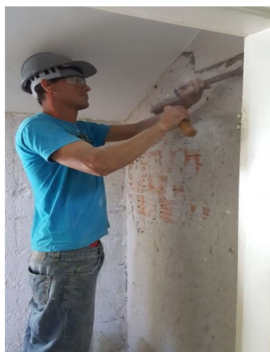
Retirada do Revestimento dos Banheiros
