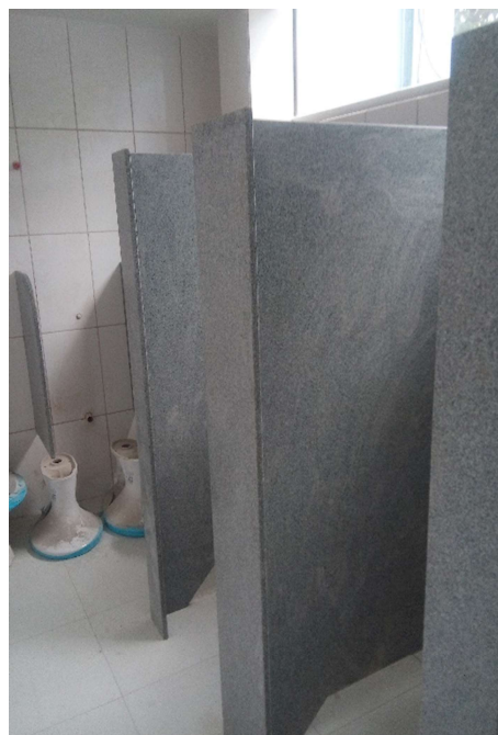
Divisória em granito instalada
