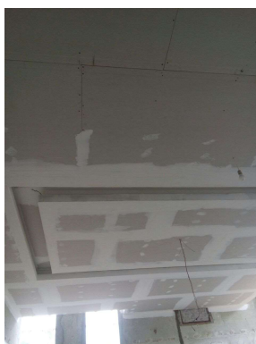
Instalação do forro de gesso acartonado
