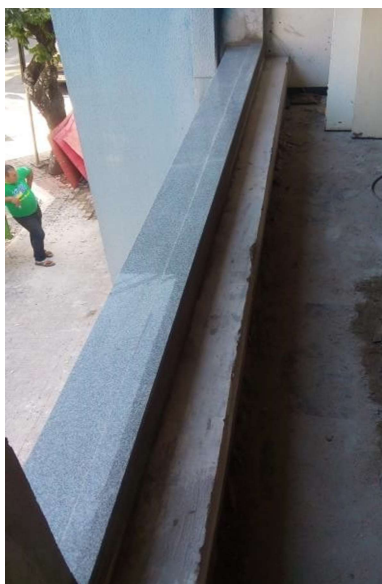
Instalação de peitoril em granito
