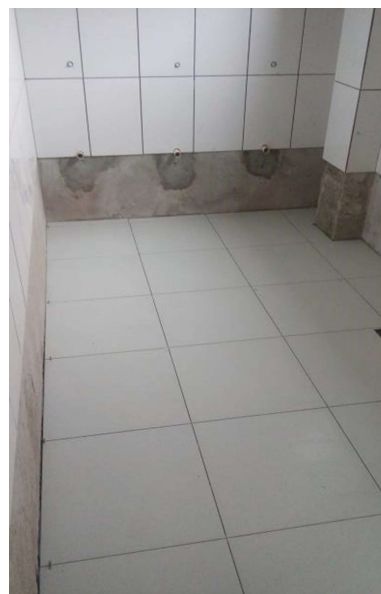
Instalação de revestimento e piso nos banheiros
