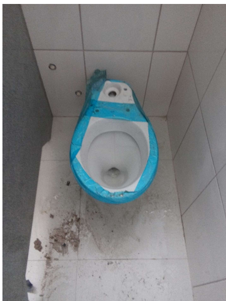
Instalação dos vasos sanitários
