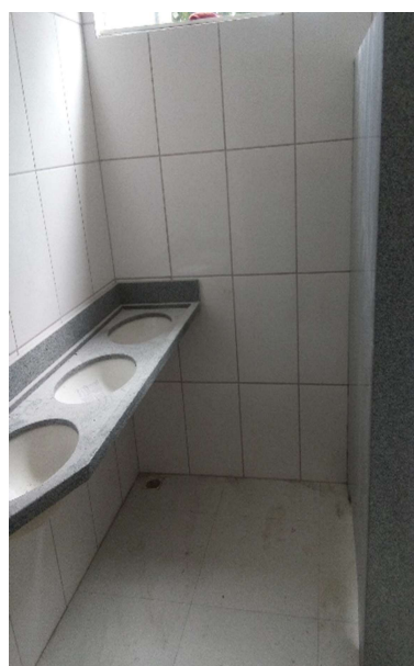
Bancada de granito com cuba embutida
