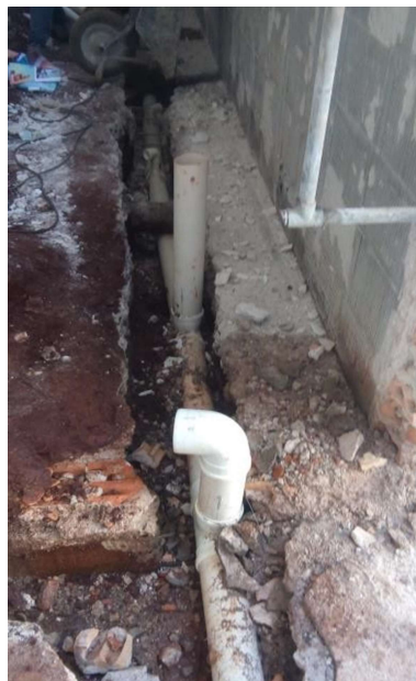
Nova rede de esgoto dos banheiros
