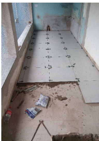
Instalação do piso cerâmico
