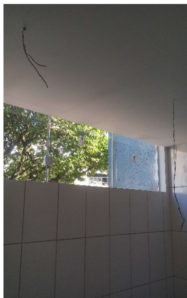
Forro de gesso instalado
