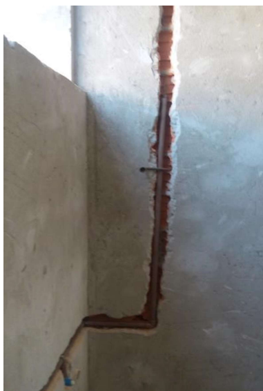
Rasgo em alvenaria/Tubulação de água fria
