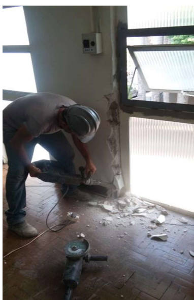
Remoção de esquadrias metálicas
