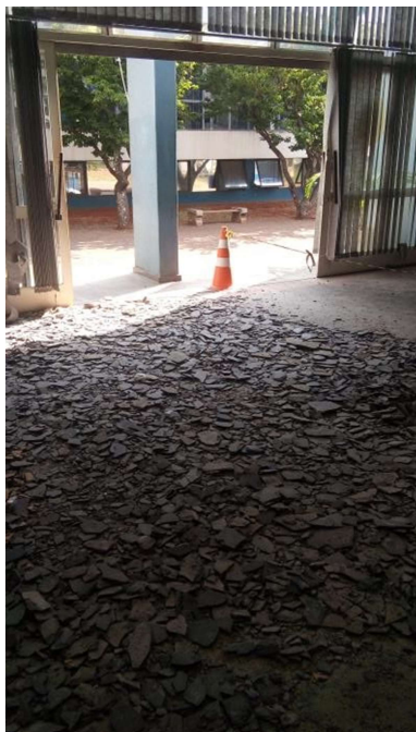
Remoção de piso Cerâmico
