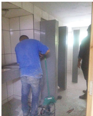
Instalação das divisórias em granito
