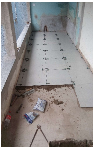
Instalação do piso cerâmico
