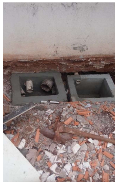
Caixas de Inspeção e Gordura
