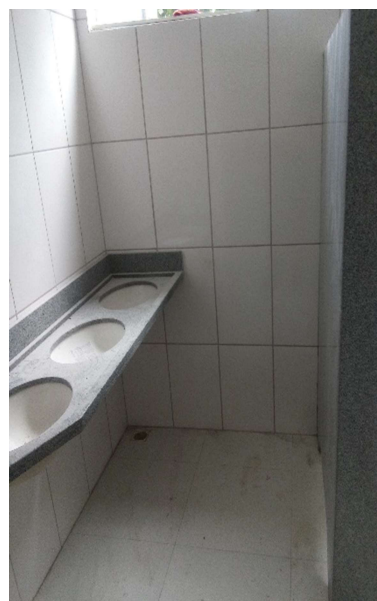
Bancada de granito com cuba embutida
