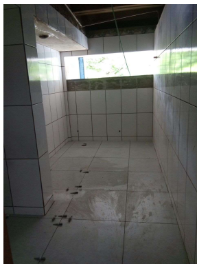
Instalação de pisos cerâmicos
