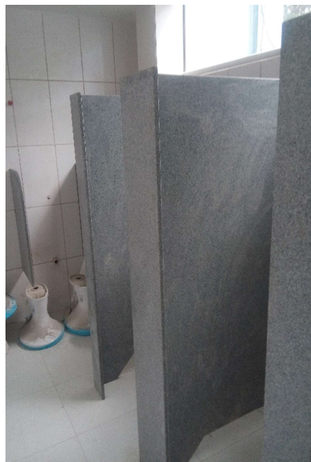
Divisória em granito instalada
