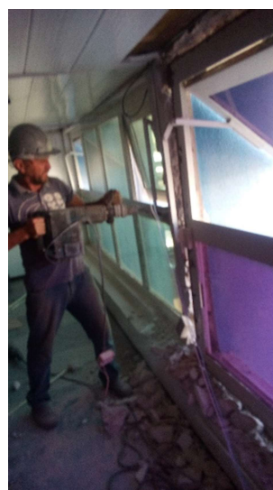
Retirada de esquadrias metálicas
