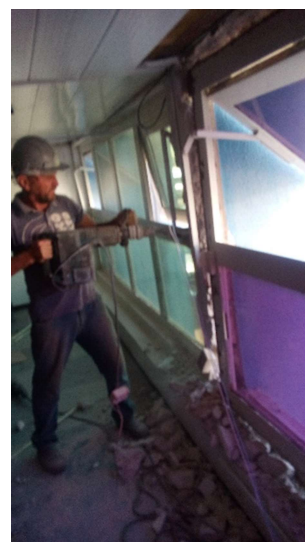
Retirada de esquadrias metálicas
