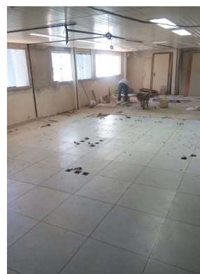
Instalação de pisos cerâmicos
