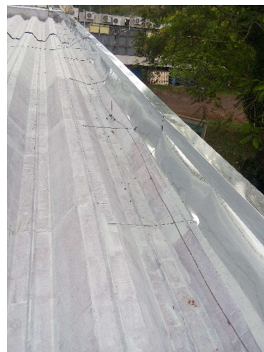
Instalação de rufo em chapa galvanizada
