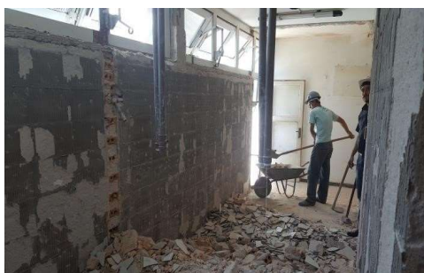
Demolição de Alvenaria/Remoção de Resíduos
