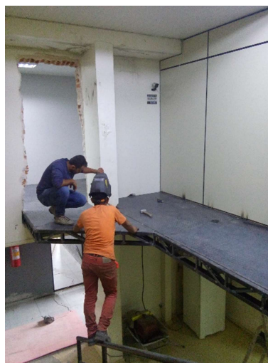
Instalação da ampliação do mezanino
